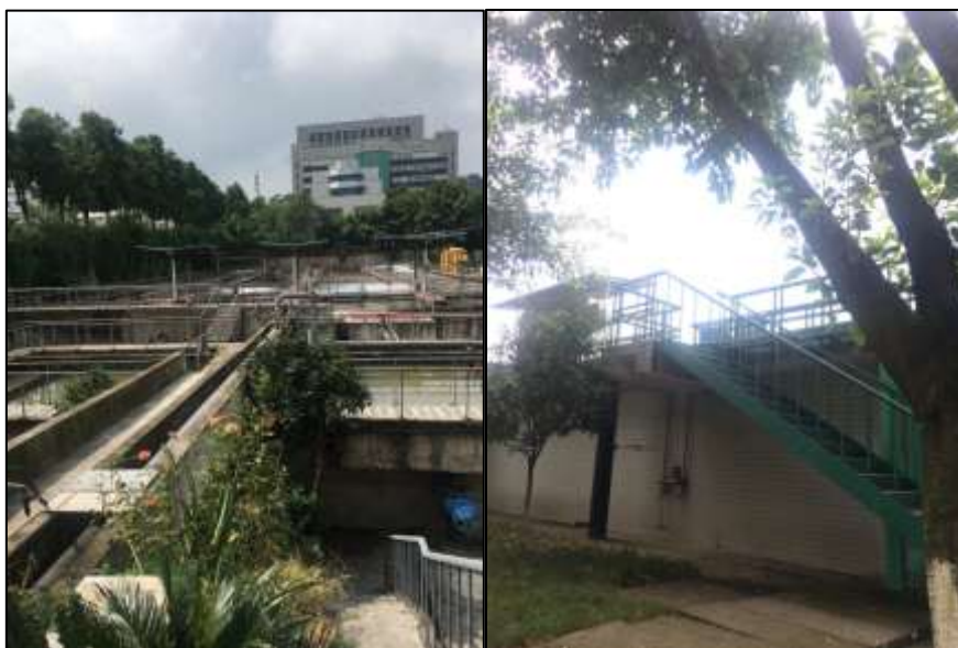
图 3.2-4 环保工程（左：第一污水处理站，右：第二污水处理站）
