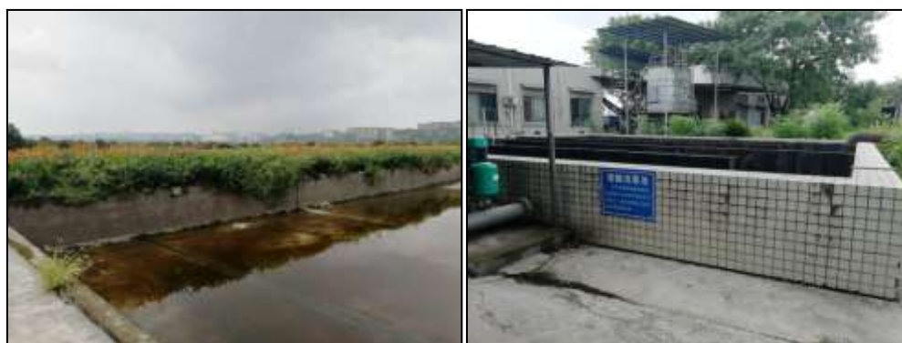
图 4.1-4 第二水处理站（左：人工湿地，右：接触池）
