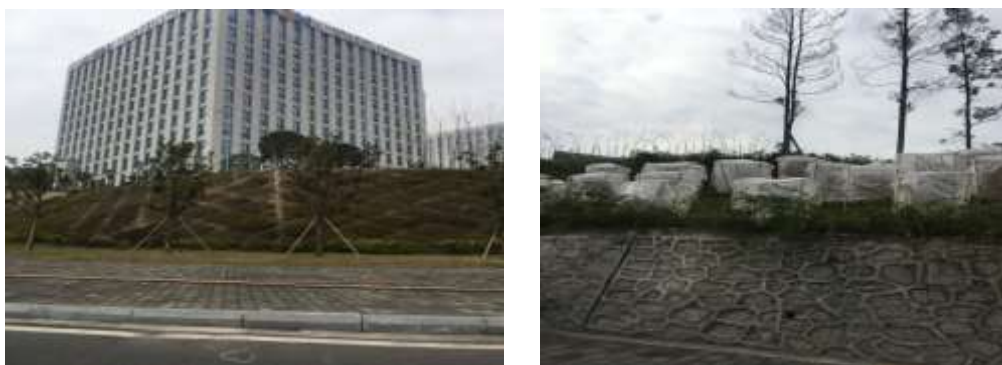
图 4.2-4 边坡防护（左：植草方格网护坡，右：砌浆片石护坡）
