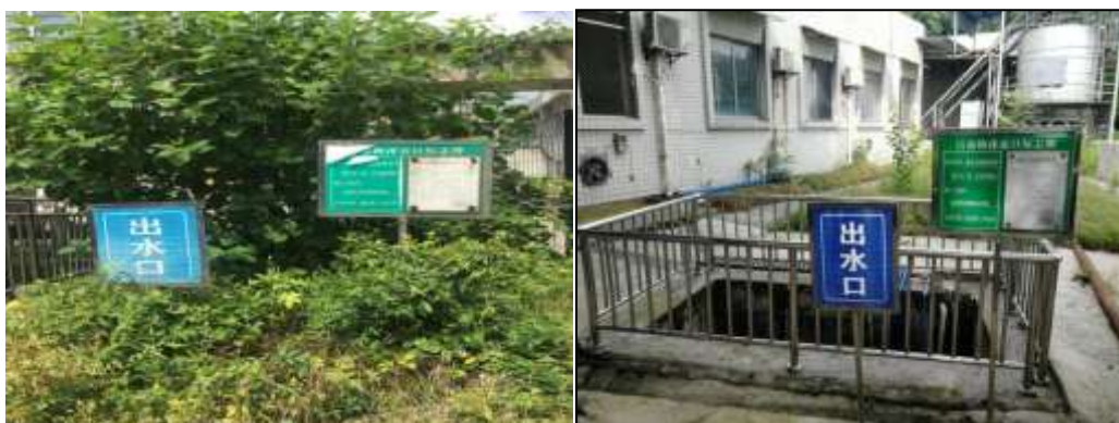
图 4.2-2 排污口规范化（左：第一污水处理站，右：第二污水处理站）
