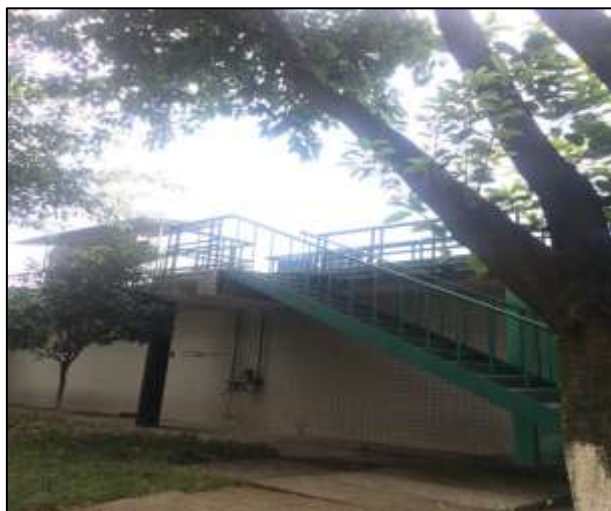
图 4.2—1 风险防范设施（第二污水处理站 SBR 反应池）
