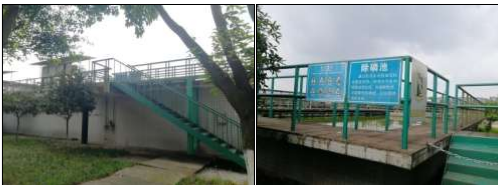
图 4.1-3 第二水处理站（左：SBR 池，右：除磷池）
