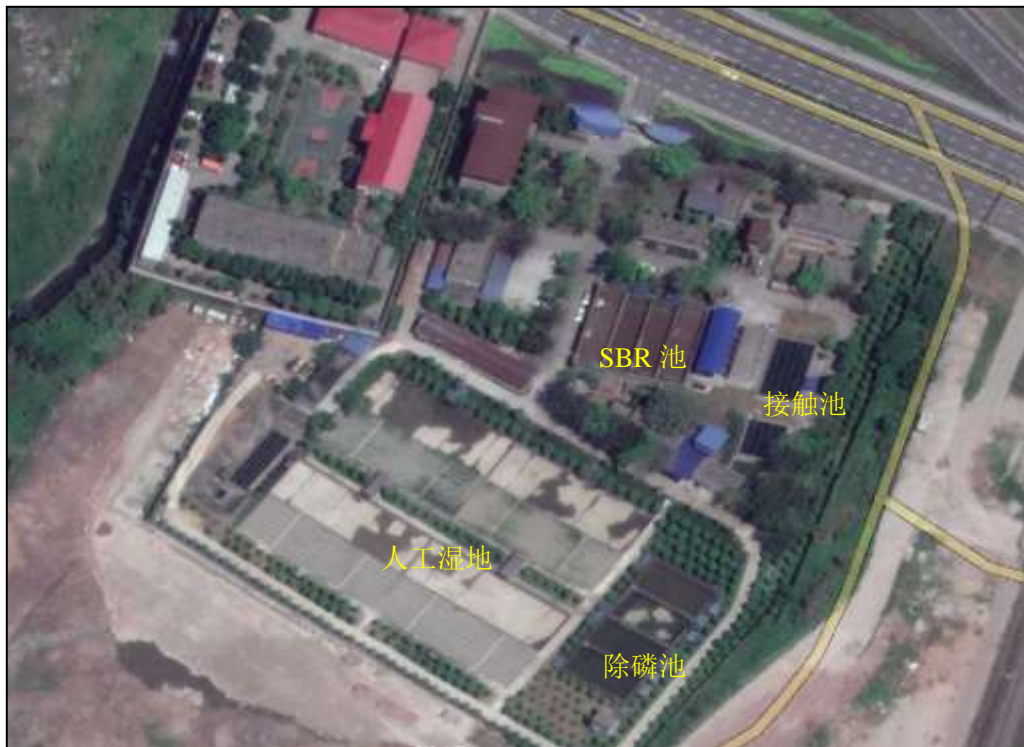
图 4.1-2 第二污水处理站
